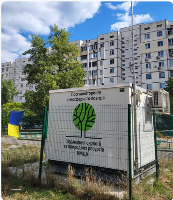
Estación oficial de control de la calidad del aire de la ciudad de Kiev
